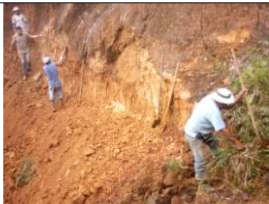
Adecuación del terreno
