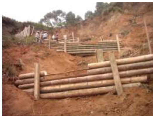
Instalación de trinchos
