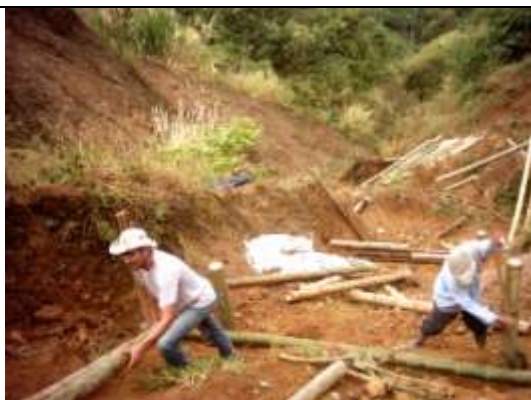
Estabilización de talud
