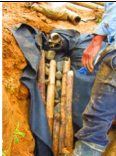
Instalación de filtros
